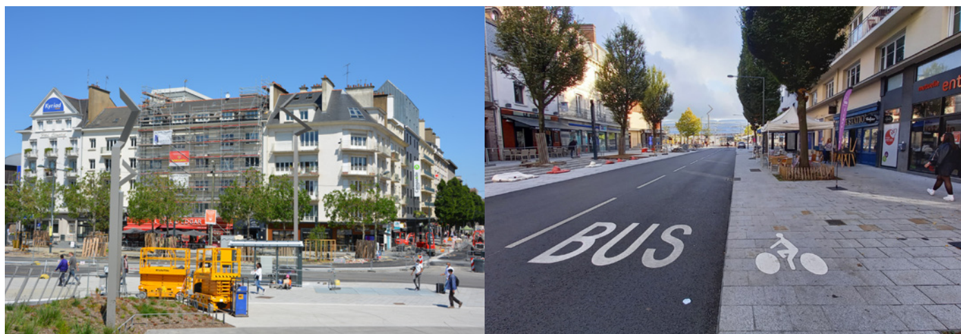
Réfection des façades et rénovation des revêtements à proximité de la gare de Rennes. Source : ESO Le Mans, 2021.
